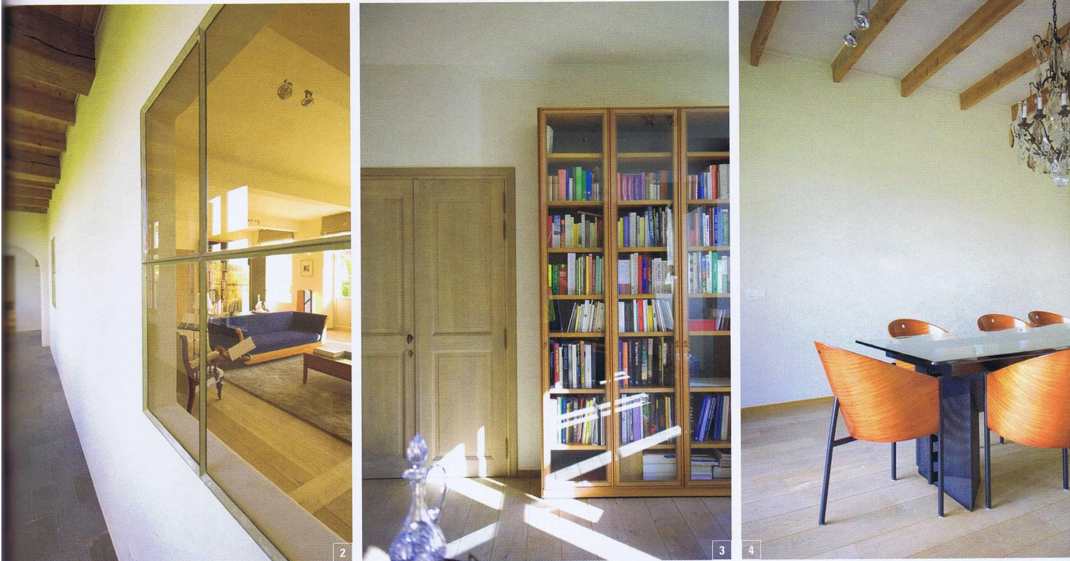
1 & 3. Kleinere kamers herleidde men tot enkele grote ruimtes (waaronder de werkkamer/bibliotheek). Allemaal met uitzicht op het erf en de tuin achteraan. 2. De binnenramen zijn ontworpen door architect Bernard De Clerck: stalen profielen, vastgezet in demuur met mastiek (oude techniek). Zo krijgen de bewoners via de hal daglicht in de leefkamers. 4. De eetkamer in het oorspronkelijke woonhuis. De verbouwing is hier zeer grondig uitgevoerd, onder meer door een betonplaat in de vloer van de begane grond en de verdieping te plaatsen. De balken in het plafond zijn niet dragend, maar decoratief.
